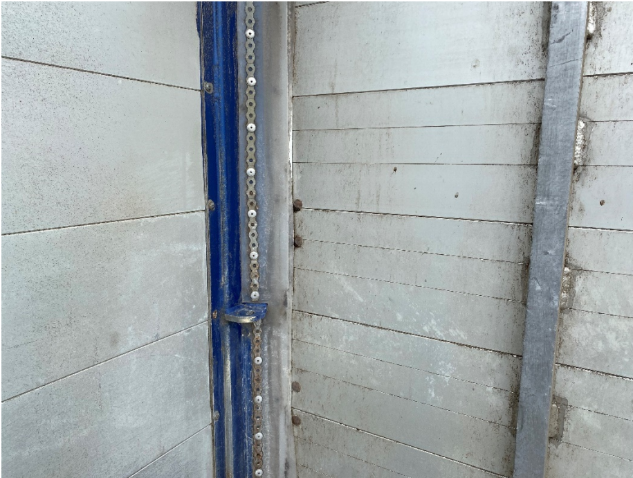
Billede 3: Kontroller/rengør ved tætningslister.
