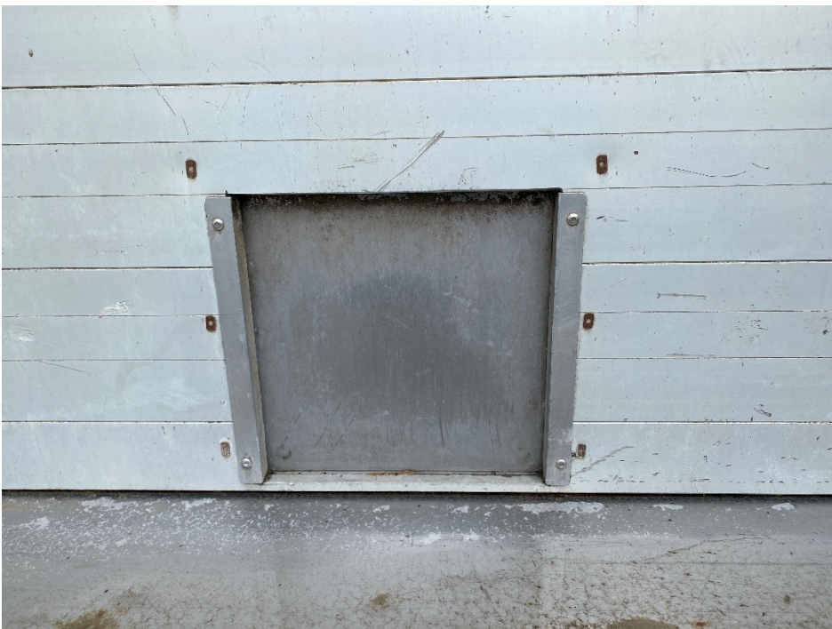
Billede 2: Kontroller/rengør ved kanter rundt ved hønselem
